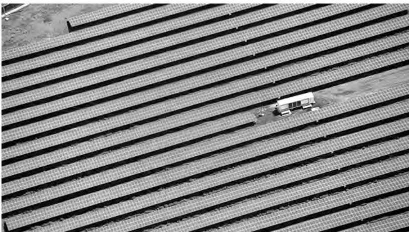
Figura 22 Vista aérea de planta de energía solar en Moncagua
