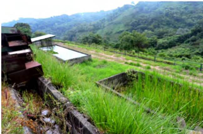
Figura 49 Contenedores de agua condensada para ser inyectada al subsuelo
